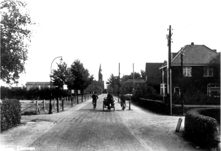
De 'telefoonpalen' langs de Kerkweg, vlak nadat deze was gemoderniseerd.
